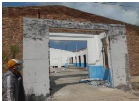
地块南侧食堂（拆除中）
