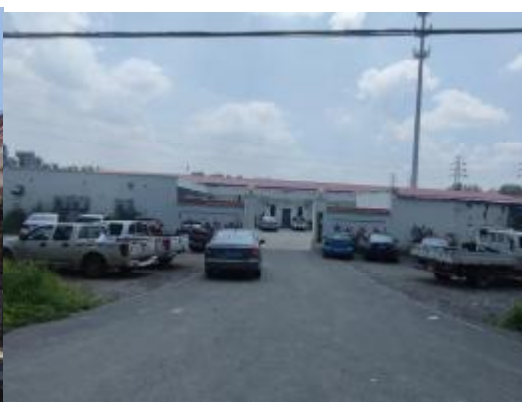
杨柳青白滩寺村供热维修站
