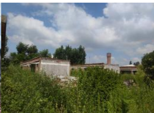
地块南侧宿舍（拆除中）
