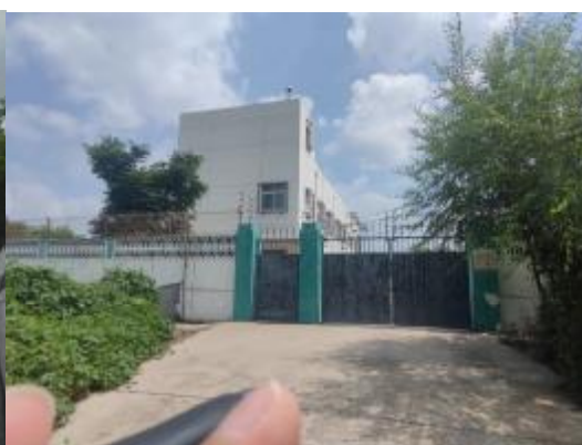
杨柳青白滩寺村变电站
