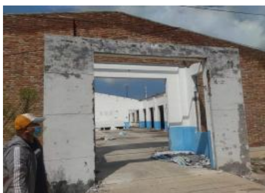
地块南侧食堂（拆除中）
