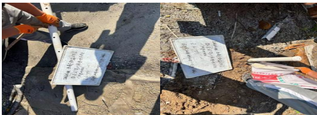
图 4-8 地下水监测井建井照片
