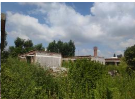
地块南侧宿舍（拆除中）
